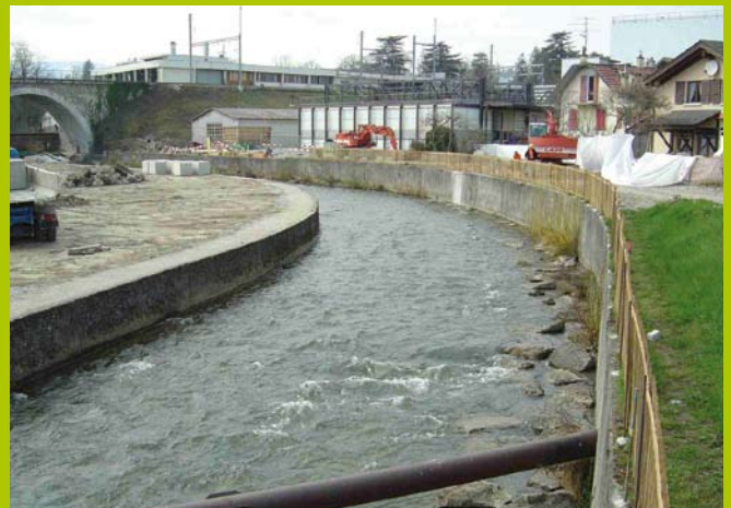
Antes de la restauración
