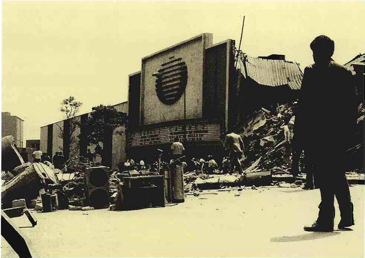
La torre de Televisa derrumbada. 1985. Pedro Valtierra/ Cuartoscuro .
