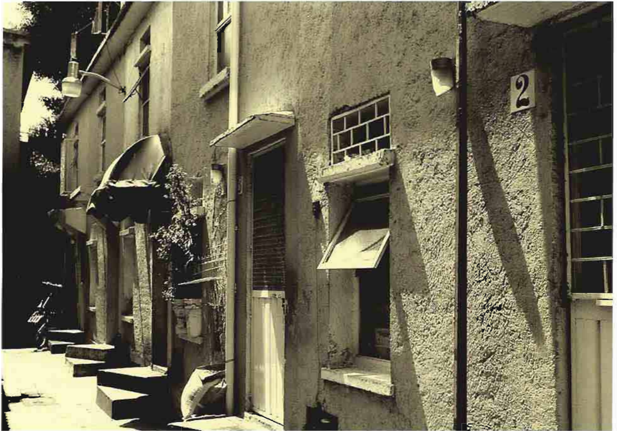
La tardanza gubernamental en las tareas de reconstrucción se evidenció en la inauguración del supuesto primer conjunto habitacional de 1997, que en realidad había sido construido con donativos de la Cruz Roja. González Ortega 15, col. Morelos, 2005. M. Tanikawa.
