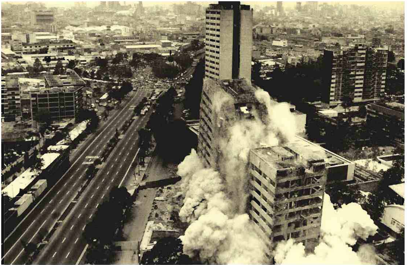
Demolición del edificio Nuevo León, 1986. Andrés Garay.
