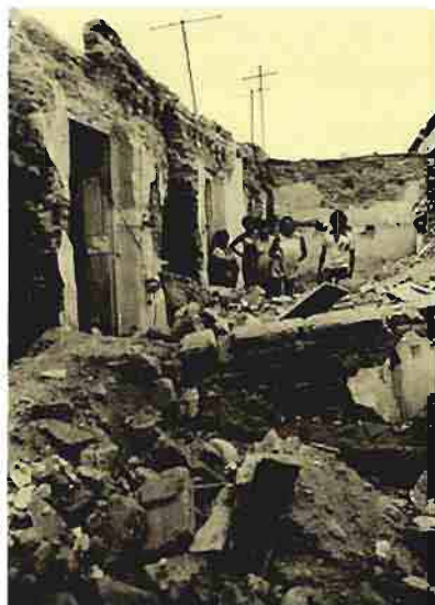
Vivienda afectada, 1985. Andrés Garay.
