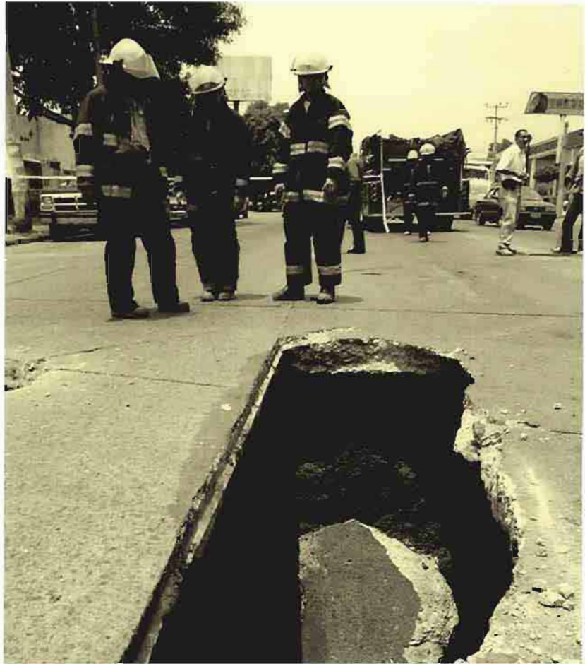
La aparición súbita de grietas en el pavimento y en la tierra está asociada a la desecación de los mantos freáticos. 2005. Archivo-Agencia Reforma .
