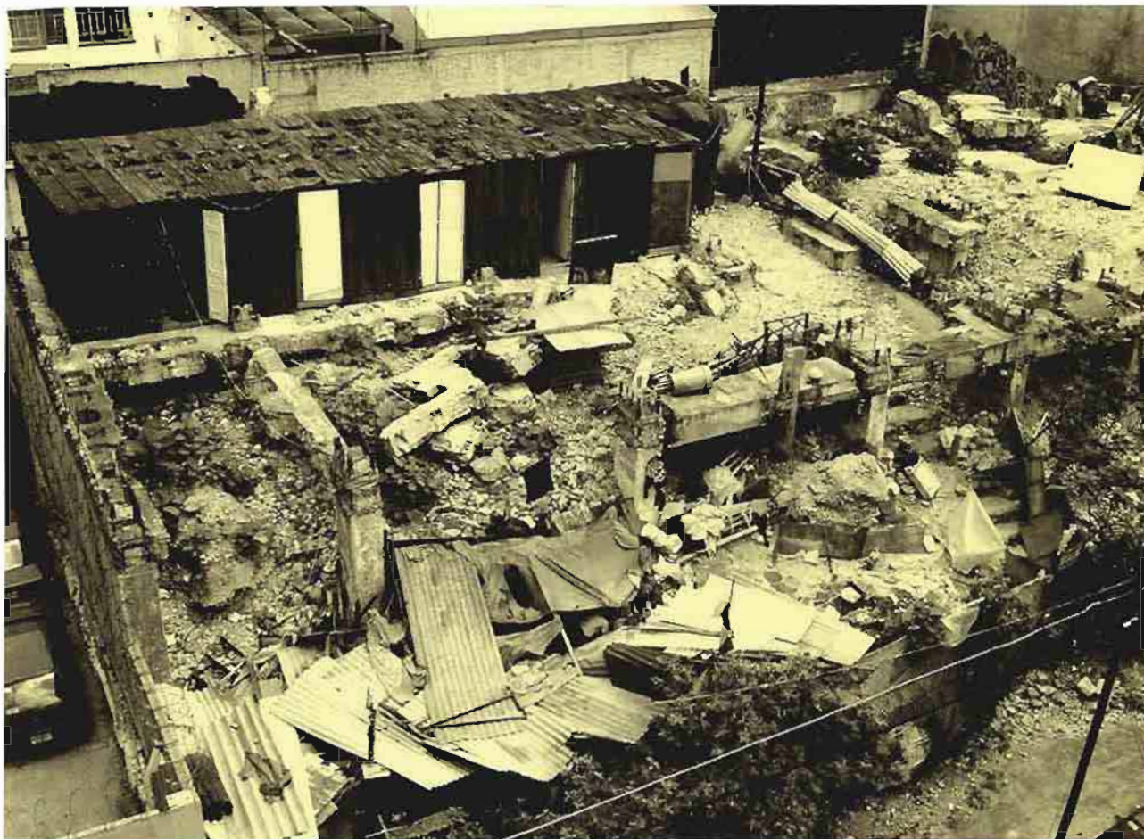
Escombros de un edificio caído en 1985 ubicado en la calle Chihuahua 191, col. Roma, 2005, Masahiro Tanikawa.
