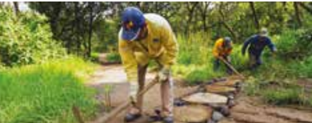
Trabajos de rehabilitación, Bosque de Tlalpan.
