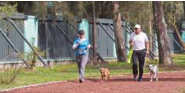
Rehabilitación de barda y malla perimetral.
