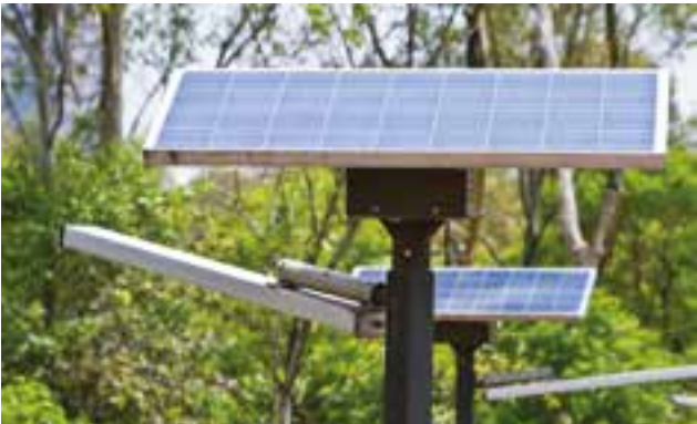
Luminaria solar, pista de corredores El Sope.
