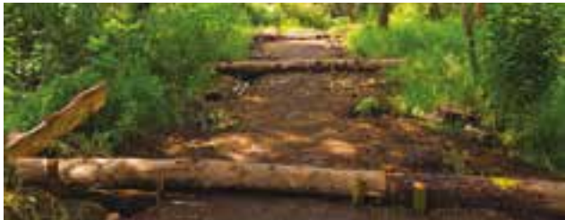
Trabajos de rehabilitación, Bosque de Tlalpan.
