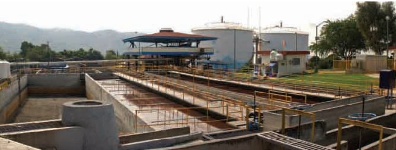
Planta de tratamiento de aguas residuales de ECCACIV, en Jiutepec. Vista general. Foto: Jorge Luis Izurieta Dávila.
