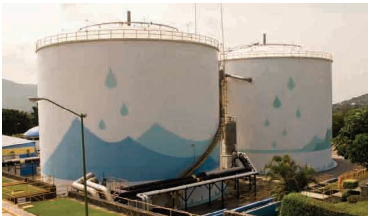
Planta de tratamiento de aguas residuales de ECCACIV, en Jiutepec. Torre de depósito.
