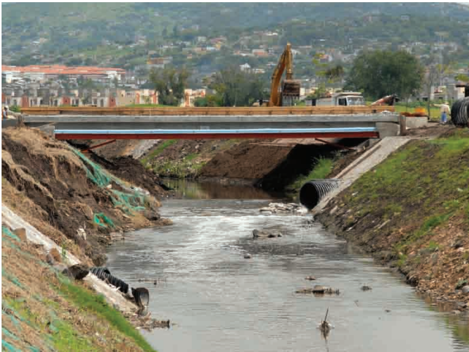
Puente sobre un canal, afluente del río Apatlaco, a su paso frente a un nuevo conjunto habitacional. Foto: Adalberto Ríos Lanz.
