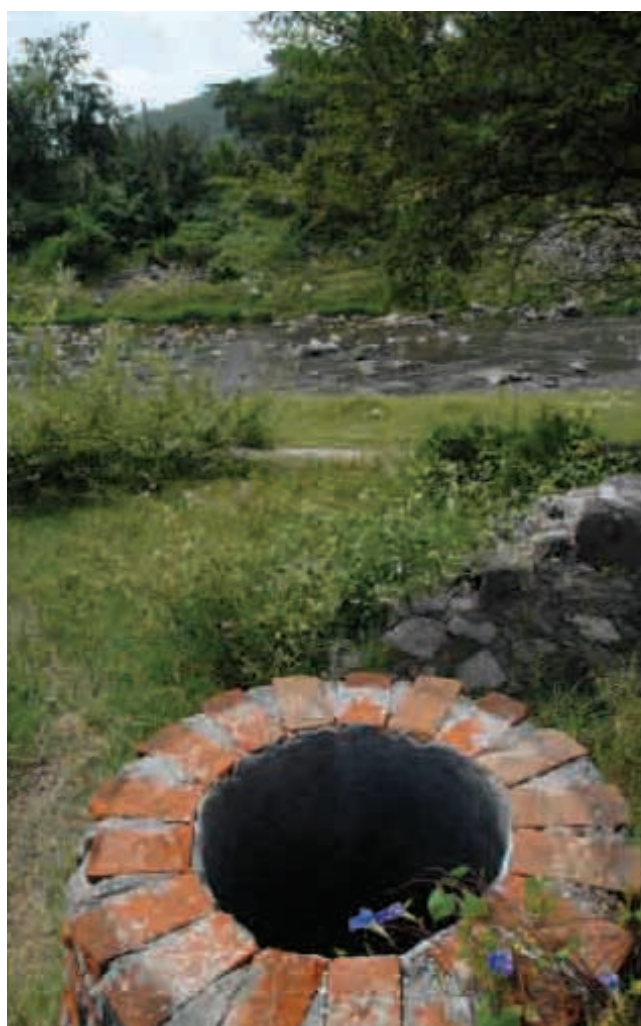
Alcantarillado sin tratamiento en Jojutla. Foto: Adalberto Ríos Lanz.
