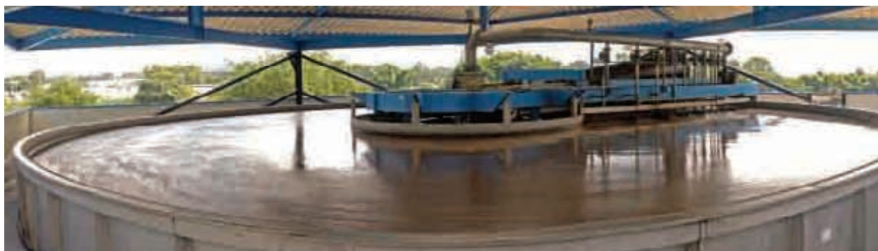
Planta de tratamiento de aguas residuales de ECCACIV, en Jiutepec. Tanque de espesamiento de lodos. Foto: Jorge Luis Izurieta Dávila.
