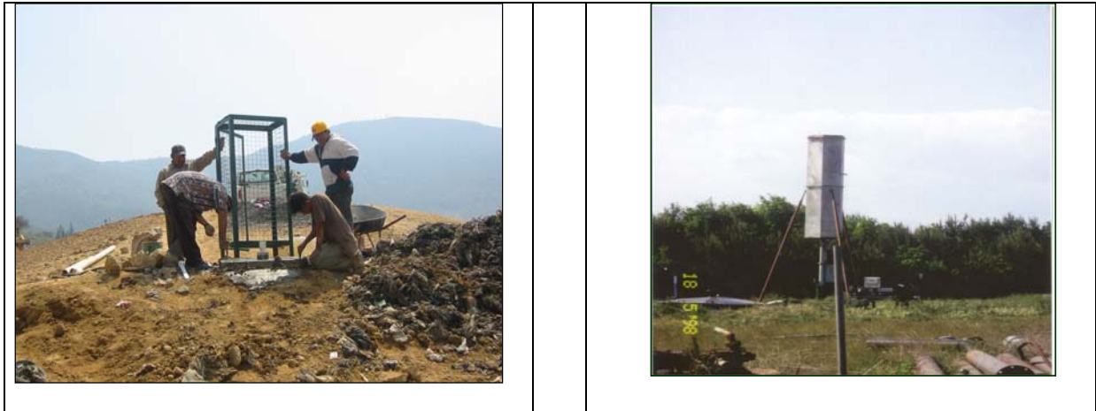
Figura 8 y 9: Quemador simples de biogás y Quemador centralizado (Fotografías: G. Wehenpohl)
