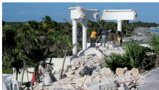
Demolición de obras en proyectos ubicados en el Parque Nacional Tulum, en Quintana Roo
