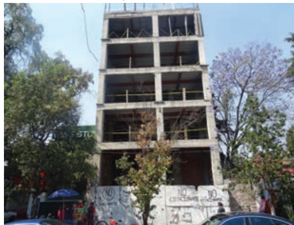
Fotografía 5. Construcción en Riobamba 648, Lindavista, Gustavo A. Madero
