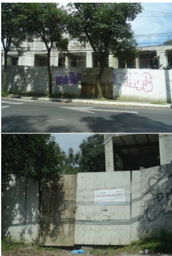
Fotografía 2. Construcción irregular en Arteaga y Salazar 770, Contadero, Cuajimalpa de Morelos
