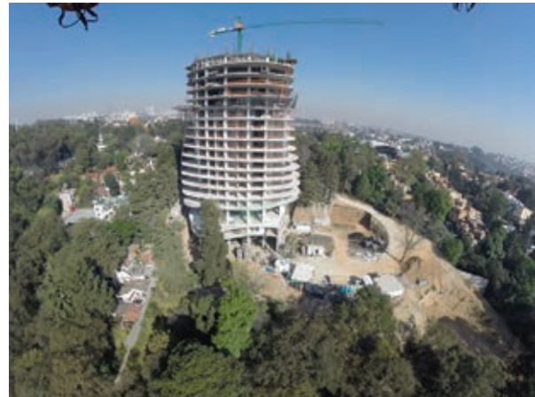
Fotografía 4. Construcción 'Península' ubicada en Desierto de Los Leones 5602, Olivar de los Padres, Álvaro Obregón
