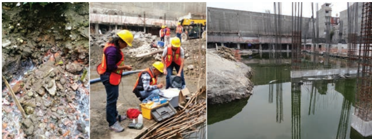
Fotografía 1. Afloramiento de agua en predio destinado a proyecto habitacional
