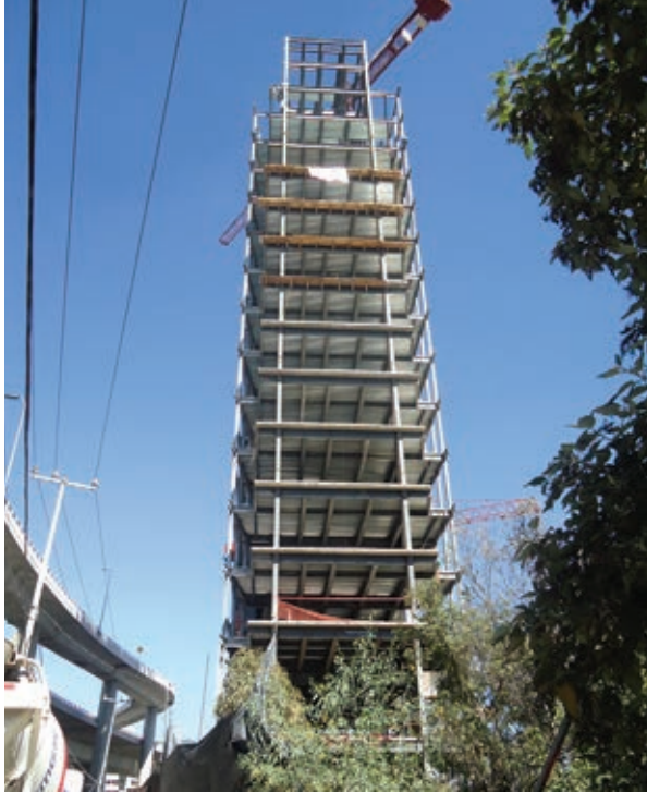
Fotografía 3. Construcción 'Presa Anzaldo' ubicada en Boulevard Adolfo Ruiz Cortines 3042, San Jerónimo Aculco, Álvaro Obregón
