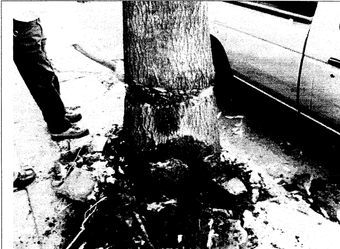
Fotografía 7. Se retiro el material que afectaba en los dos cortes que presenta el árbol así como los que se encontraba en la base.
