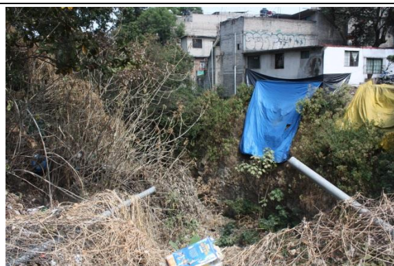
Figura 30. Asentamientos de alto riesgo porque se erosiona el suelo donde están cimentados. Colocan las lonas para evitar la erosión.
