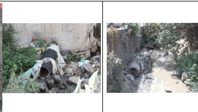
Figura 35. Materiales de la construcción depositados sobre el cauce que favorecen la acumulación de otros residuos.
