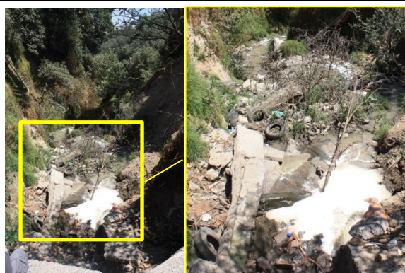
Figura 6. Se muestran los residuos presentes en el cauce.
