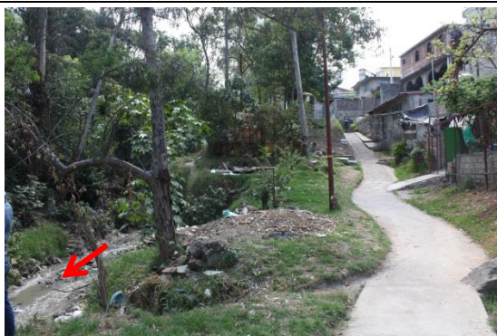
Figura 28. Vista general del cauce en el sitio 7.
