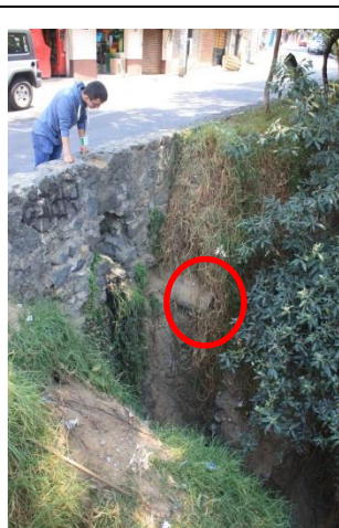
Figura 20. Tubo que descarga drenaje.
