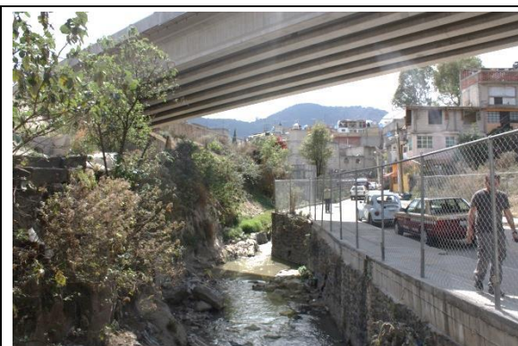
Figura 32. Vista general del cauce en el sitio nueve. Arriba pasa la obra de Supervía Poniente.
