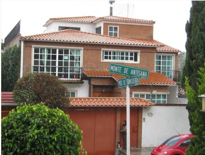
Fachada principal del inmueble relacionado con los hechos denunciados, que consta de 3 niveles y un semisótano
