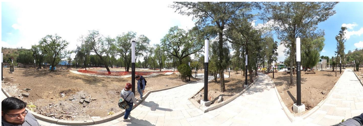
Imagen 11. Obras en proceso zona oriente del Parque.
