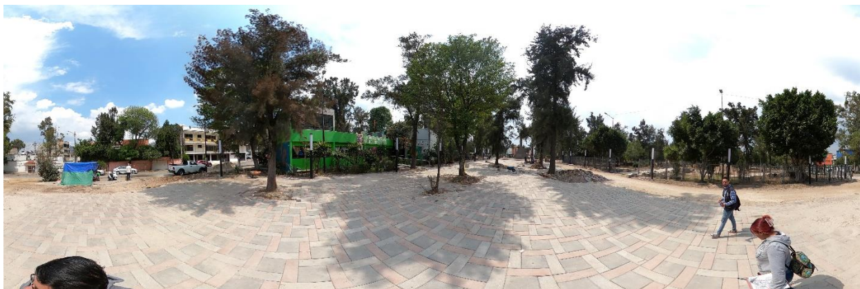
Imagen 10. Obras en proceso zona central del Parque.
