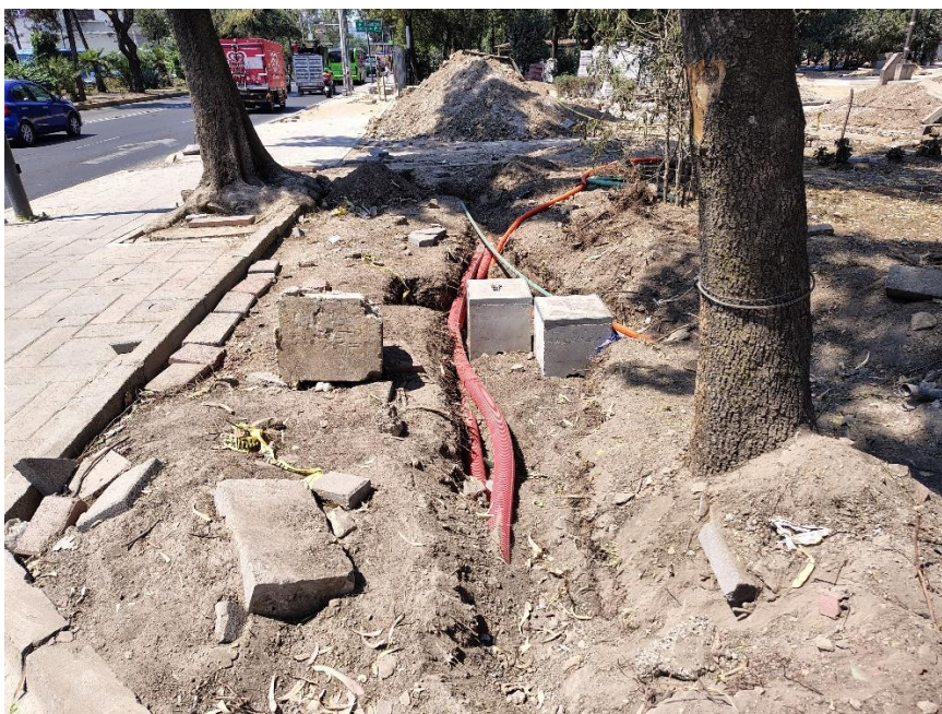
Imagen 15. Corte de raíces secundarias por la excavación de zanjas.
