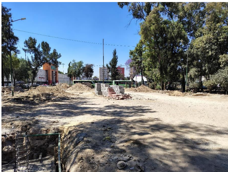
Imagen 12. Zona céntrica del Parque con mayor impacto en el suelo por las obras.
