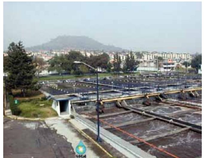
En el estado de Hidalgo, se tienen sólo cuatro plantas de tratamiento en operación cuya capacidad total instalada es de 36 litros por segundo y en el año 2007 trataron un caudal de 28 litros por segundo. Dos de ellas trabajan con lagunas de estabilización, una a través del proceso de fosa séptica y otra con biodiscos.
