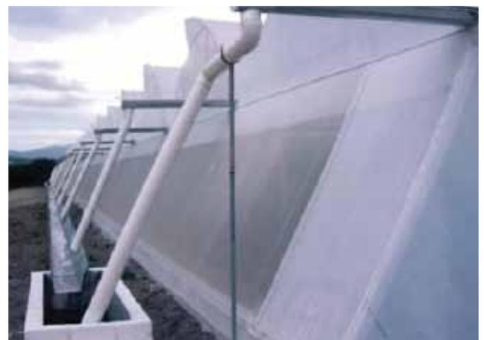
El Cidecalli diseñó un sistema para almacenar agua captada en los techos de los invernaderos y mantenerla en condiciones de calidad adecuada para riego, incluso con el sistema hidropónico. La capacidad de almacenamiento es de dos mil metros cúbicos.
