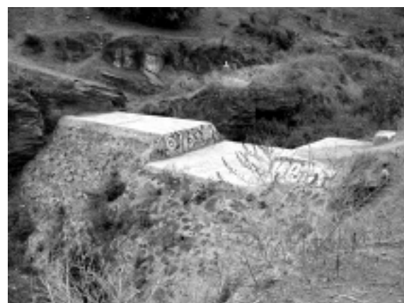
Fig. 38. Presa reguladora de avenidas (rompe-picos).
