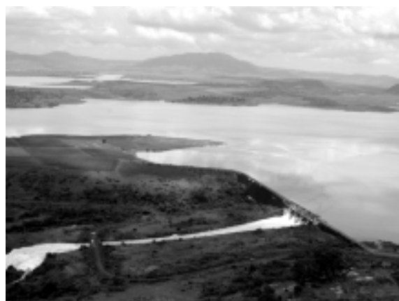
Fig. 37. Presa de almacenamiento.
