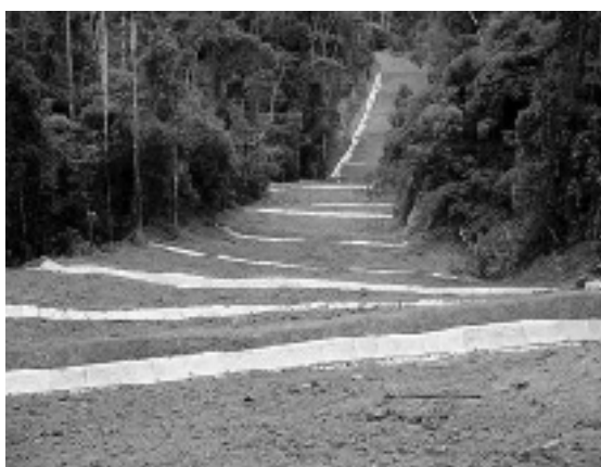
Fig. 39. Estabilización de pendientes.
