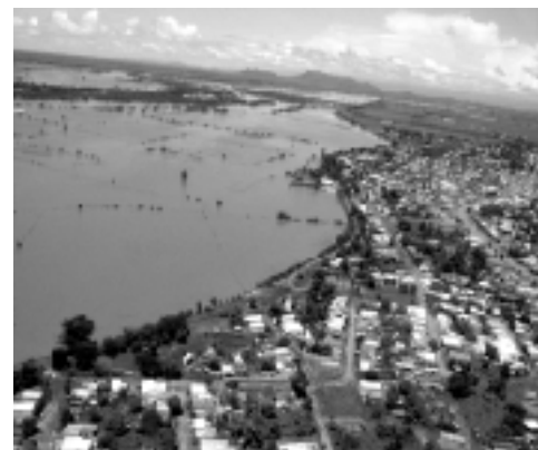
Fig. 43. Bordo longitudinal sobre el río Santiago , Nay.
