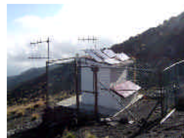
Estación sísmica Canario
