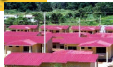
Viviendas con techos de lámina. Fuente: www.correagua.com/productos
