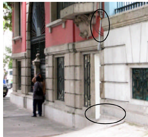
Asentamiento diferencial entre edificios vecinos.
