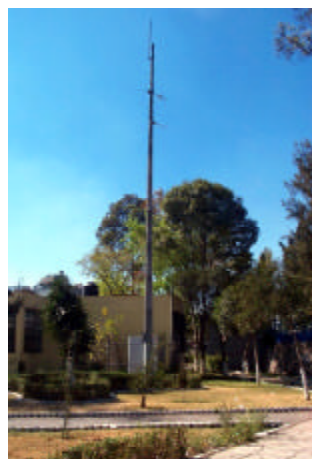
Estación Zaragoza, antena de comunicación
