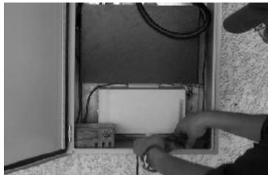
El sistema de sincronización de CENAPRED y cuya función es generar una señal para el registro del tiempo en las estaciones de la ciudad de México, se reparó y restableció mediante el mantenimiento al microcontrolador, la reparación de radios tipo «scanner» y a los sistemas de disparo remoto, de esta forma se garantiza que se obtengan registros de alta calidad, confiables y exactos.
