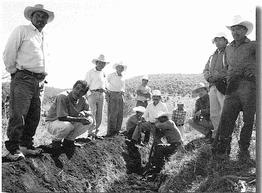
Figura 23. Campesinos de la Mixteca Alta hacen una pausa para explicar a los consultores la labores de construcción de una zanja para retener el agua de lluvia.
