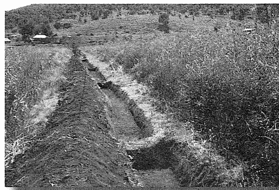
Figura 10. Zanja trinchera para contener la erosión y capturar agua, cerca de Apoala.
