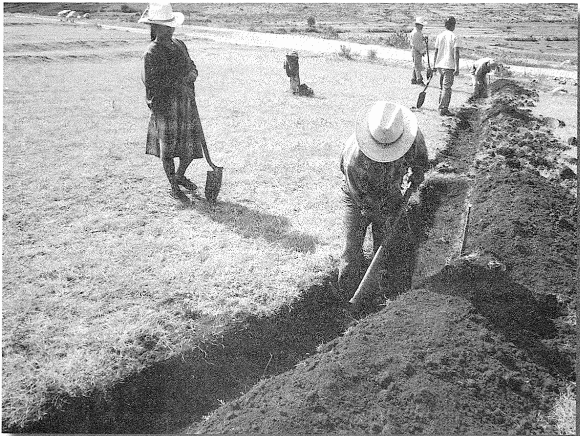
Figura 5. Construcción de zanjas y diques de contorno para retener el agua y disminuir la erosión cerca de Apoala, en la Mixteca.
